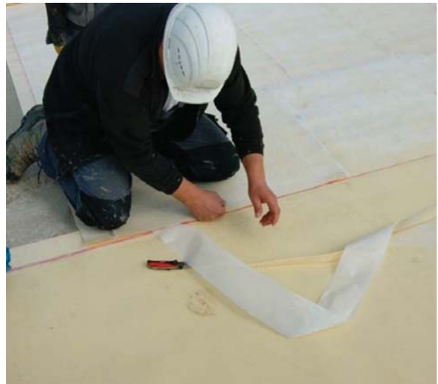
Bild 1. Verlegung eines Frischbetonverbundsystems
