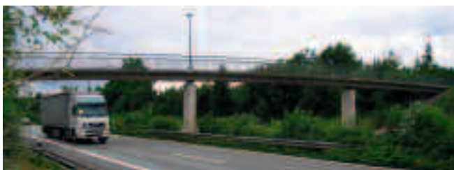
Bild 2. Geh- und Radwegebrücke Heidegrundweg über die A 33 bei Bielefeld, Vorspannung durch interne Spannglieder ohne Verbund, Baujahr 1991
