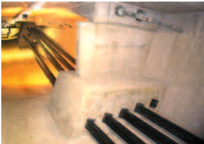
Bild 1. Mühlenbergbrücke – Vorspannung ohne Verbund mit internen und externen Spanngliedern, Bau 2005 bis 2006
